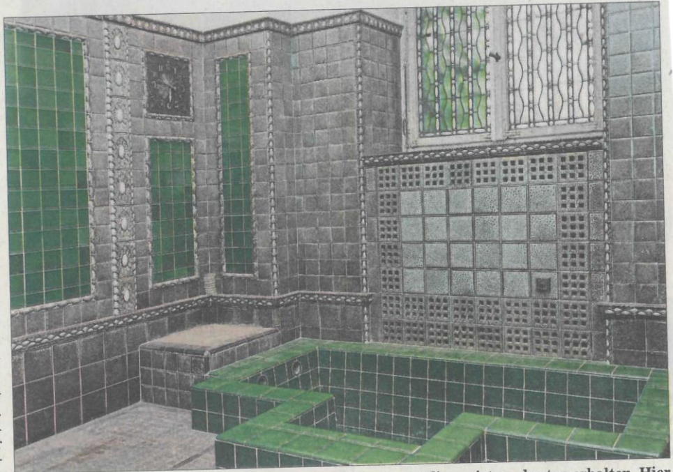
Der Baderaum des Fürstenbads mit seinen dunkelgrünen Fliesen ist am besten erhalten. Hier müssen nur ein Wandteil und die Decke erneuert werden. (Fotos: Hiltrud Hölzinger/pv)
